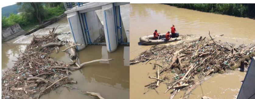
Decolmatarea pârâului Moșna în zona izvorului, acțiune realizată de către Apele Române-decembrie 2017
