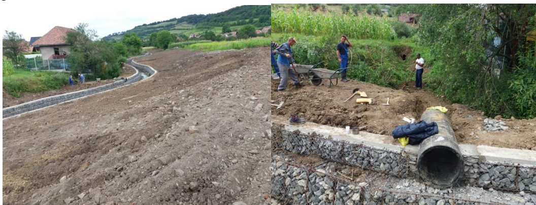
Regularizare pârâul Moșna, aval de podul de pe str. Moșnei – lucrare executată de Apele Române
