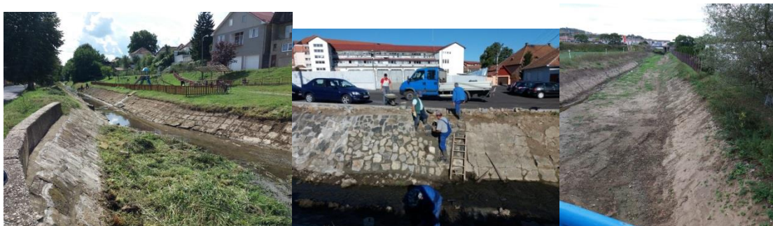
Lucrări de curățire și reparații pereu pârâul Moșna zona Valea Adâncă; Str. Nicolae Grigorescu executate de Apele Romane - septembrie 2017 și pârâul Ighiș in zona SC Kromberg
