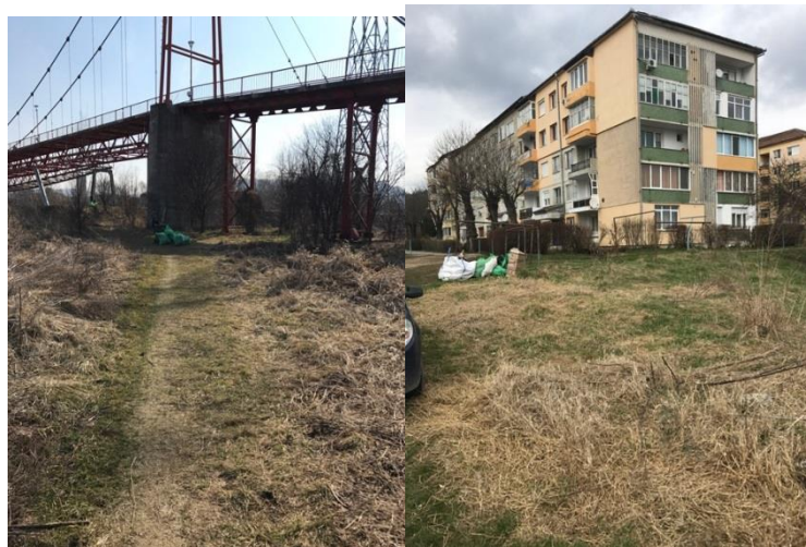
Râul Târnavă Mare – Pasarela Gura Câmpului
